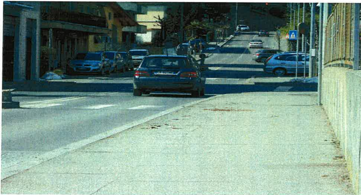
2. L'attuale marciapiede sul ponte verso il parco della Villa De Strens.
