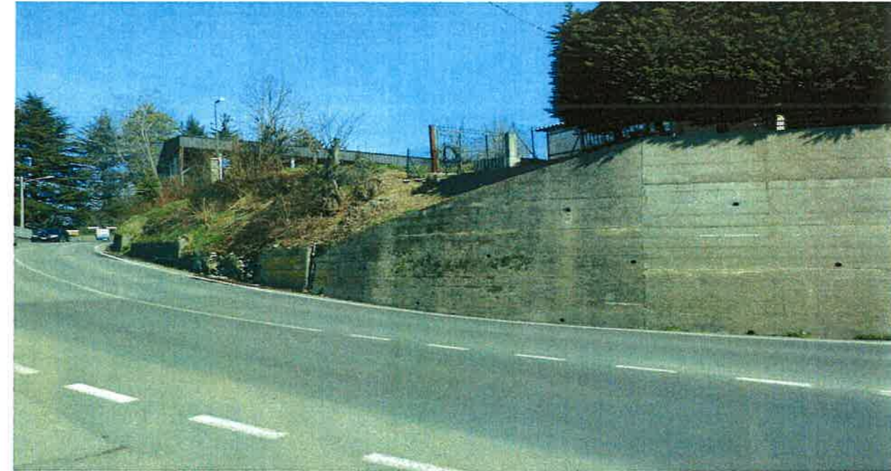
1. Vista del muro di contenimento Via Adua.
