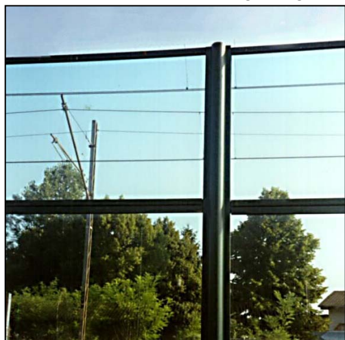
Fig. 14.A Realizzazione di barriera con montante arrotondato sulla linea Udine-Tarvisio
